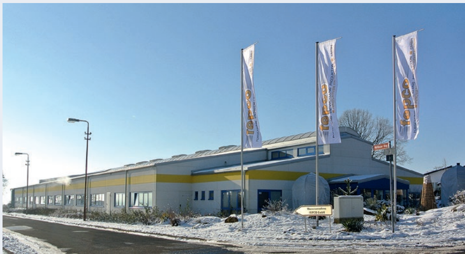
Am Standort Zweibrücken beschäftigt die Fepco GmbH 32 Mitarbeiter. Schwerpunkt des Unternehmens ist die Industriefiltration. Foto: pr
